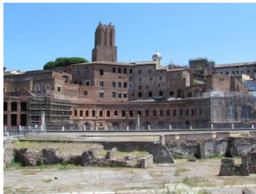
Figura 2. Mercado de Trajano, em Roma, onde se pode observar no segundo piso, o espaço de circulação, composto por arcos, para acesso à lojas dos artífices.
