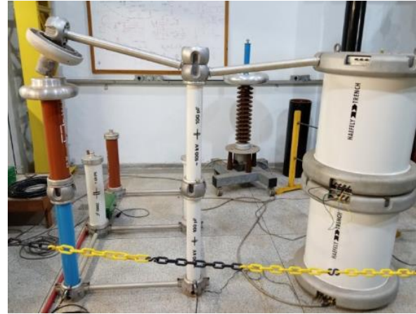
Fig. 4. Circuito final do ensaio AC com dois transformadores conectados em cascata.
