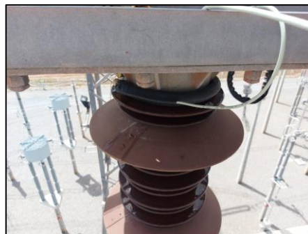
Fig. 10 Bobina de Rogowski na chave seccionadora.
