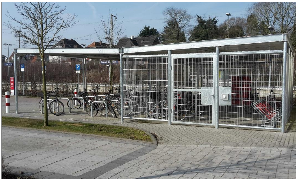
Abb. C-5: Gutes Beispiel: In Osterholz-Scharmbeck wurde am Bahnhofsvorplatz eine gut einsehbare Bike-and-ride-Anlage errichtet. Im abschließbaren Teil wurden zudem Schließfächer mit Lademöglichkeit für Pedelecs/E-Bikes integriert. (Foto ZVBN)
