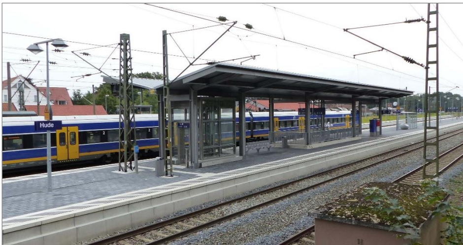
Abb. C-3: Gutes Beispiel: Am Bahnhof Hude wurde auf dem Mittelbahnsteig ein Bahnsteigdach und damit ein verbesserter Schutz gegen Niederschläge errichtet. (Foto ZVBN)
