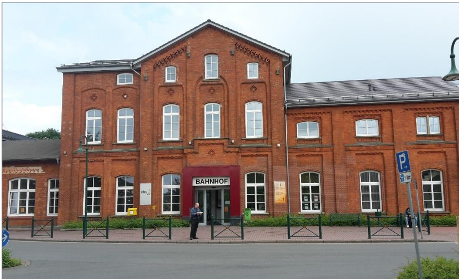
Abb. C-13: Gutes Beispiel: Das Bahnhofsgebäude von Bassum ist in den letzten Jahren in Regie der Stadt Bassum grundhaft saniert und modernisiert worden. Neben einem Reisebüro mit Fahrkartenverkauf, einem Backshop mit Lounge, Warteraum und Toiletten konnten auch öffentliche Einrichtungen wie Volkshochschule und Musikschule integriert werden, so dass die Wiederbelebung des historischen Gebäudes bestens gelungen ist. (Foto ZVBN)
