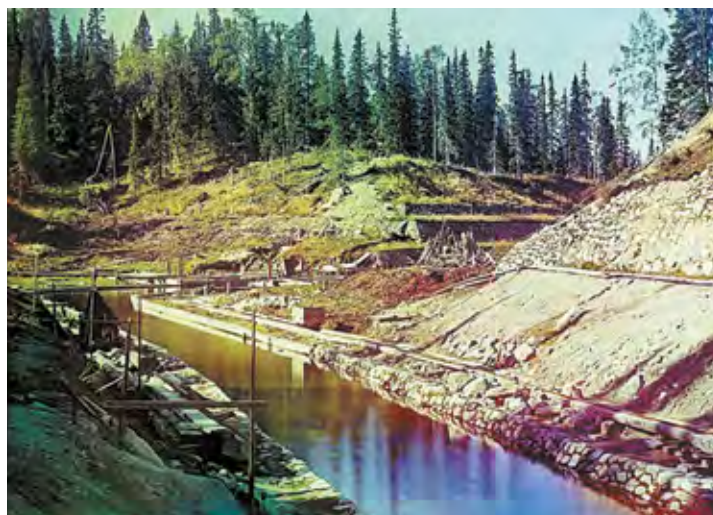
Строительство канала. 1916 год. Водная система Святого озера включала 65 озёр, 69 каналов, 16 дамб и шесть плотин
