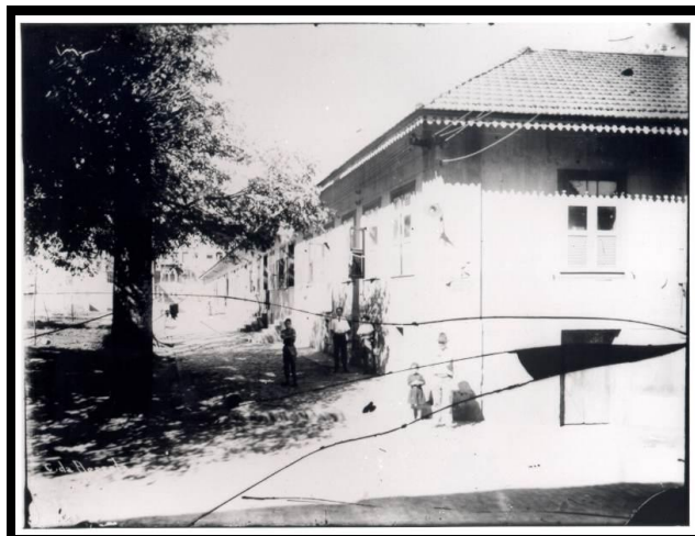
Figura 5. Fachada do cortiço Chácara da Floresta , na Rua da Ajuda (RJ). Fonte: MALTA, [19--].
