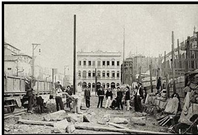
Figura 10. Bota-abaixo: demolições para a construção a Avenida Central. Fonte: TORRES, 1904-1905.
