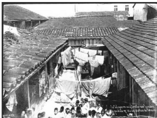
Figura 4. Estalagem localizada na Rua do Senado (RJ). Fonte: MALTA, 1906c.
