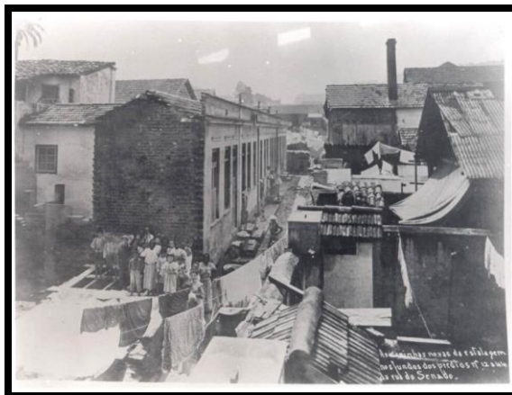
Figura 3. Casinhas novas da estalagem nos fundos dos prédios números 12 a 44 da Rua do Senado (RJ).
