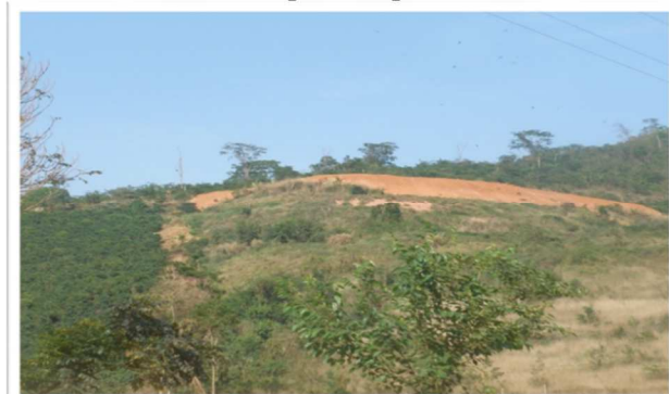
Figura 07: Vista frontal do aterro controlado
