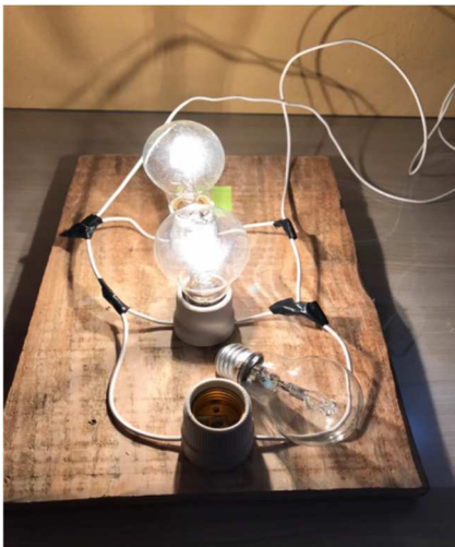
Figura 5: Circuito em paralelo em teste para ver se a corrente seria interrompida. (Ana Luísa Moreira Brandão, 2018).
