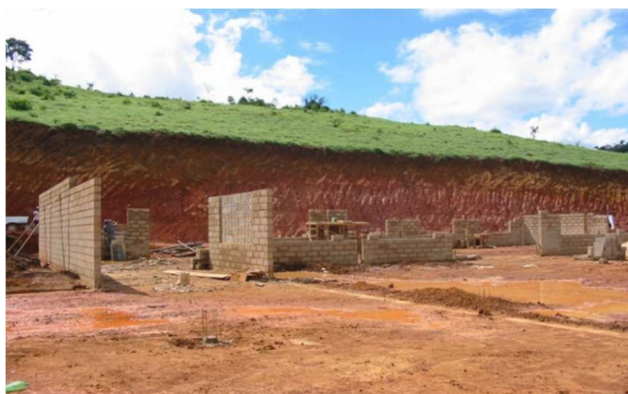
Figura 01: Vista parcial da construção da UTCL- 2007
