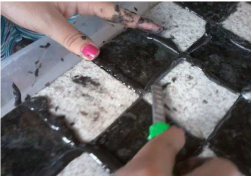
Fig. 9: Retirada do excesso de cola (Autor, 2011).
