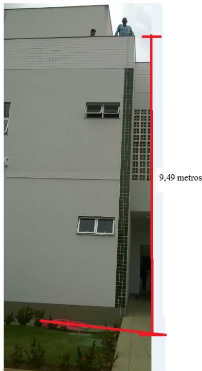
Fig. 2: Medição da altura real do prédio do Bloco B.
