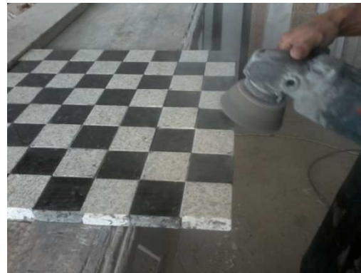
Fig. 12: Rebolo 120 para retirada de quinas (Autor, 2011).
