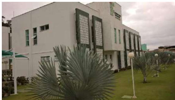
Fig. 3: Edifício IFES – (Fonte: Arquivo Pessoal, 2016).
