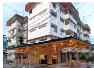
[22] Ativação de esquina a partir de comércio. Restaurante La pesca. Fonte: Natura Futura Arquitetos. Fotografia: KLIWADENKONOVAS Fotografia
