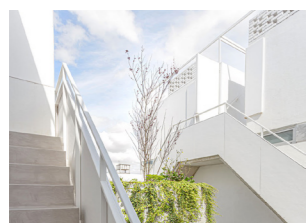
[11] [12] [17] O pátio no centro do edifício garante a iluminação e ventilação cruzada nas unidades. As escadas funcionam também como limitadoras de expansões dentro do pátio Fonte: Alonso & Crippa.. Fotografia: Javier Agustin Rojas y Daniel Karp.
