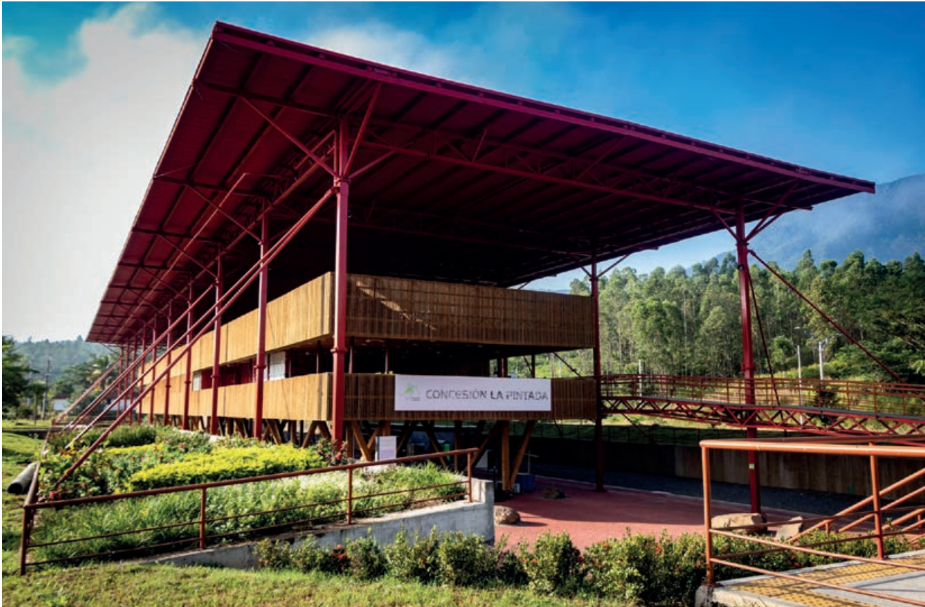
Centro de Control de Operaciones Pacifico 2 Antioquia
