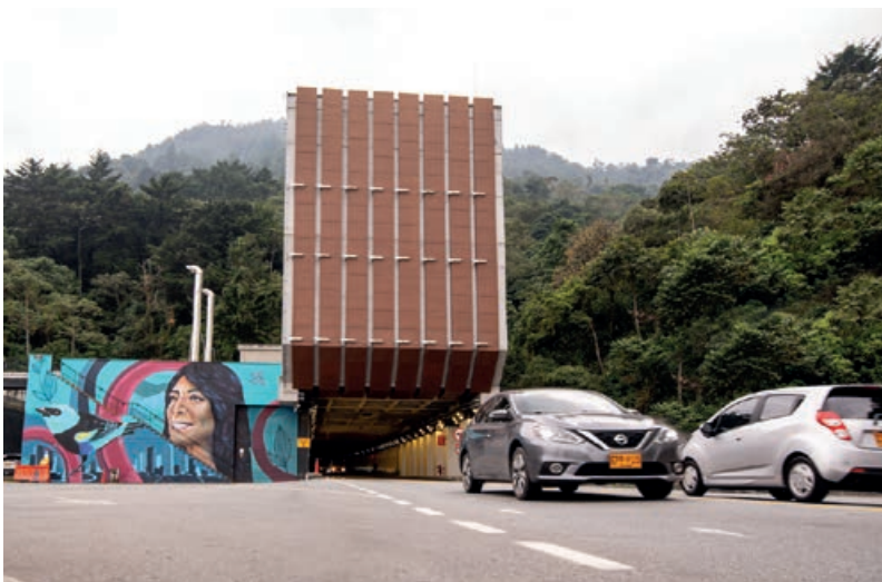
Túnel de Oriente Antioquia
