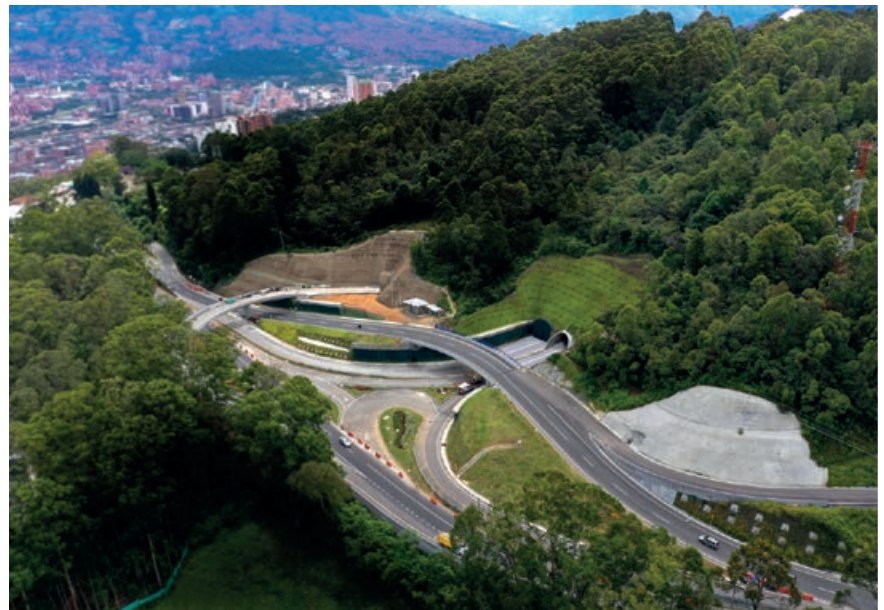
Túnel de Oriente Antioquia
