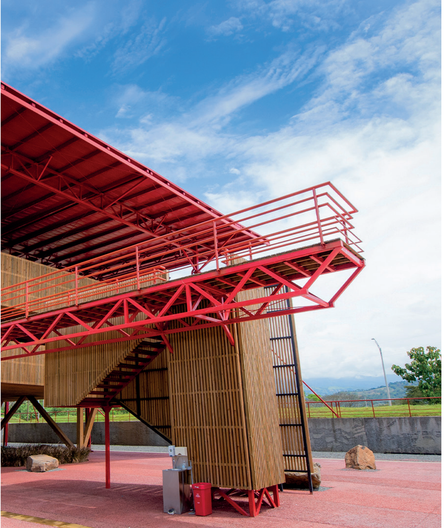
Centro de Control de Operaciones Pacífico 2 . Antioquia
