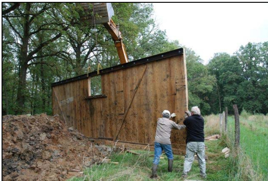
Einsetzen der Spundwand im Wahrenberger Polder
