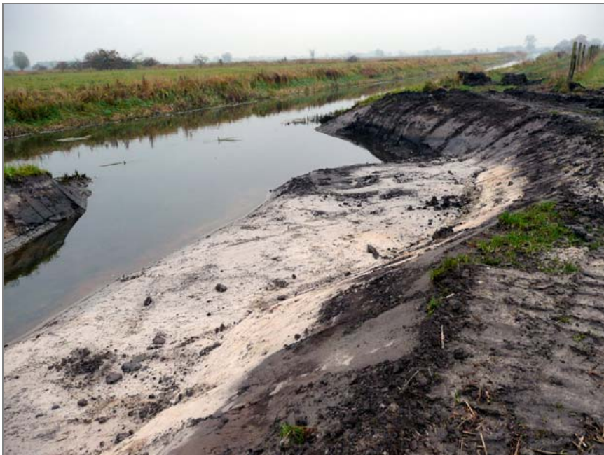
Eine von drei Graben- aufweitungen an der Karthane
