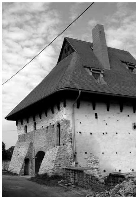
Obr. 16. Bašta – Pracháreň v Levoči po obnove, so zvýraznenou neomietanou staršou zabudovanou priebežnou hradbou v južnej stene. Foto M. Janovská.
