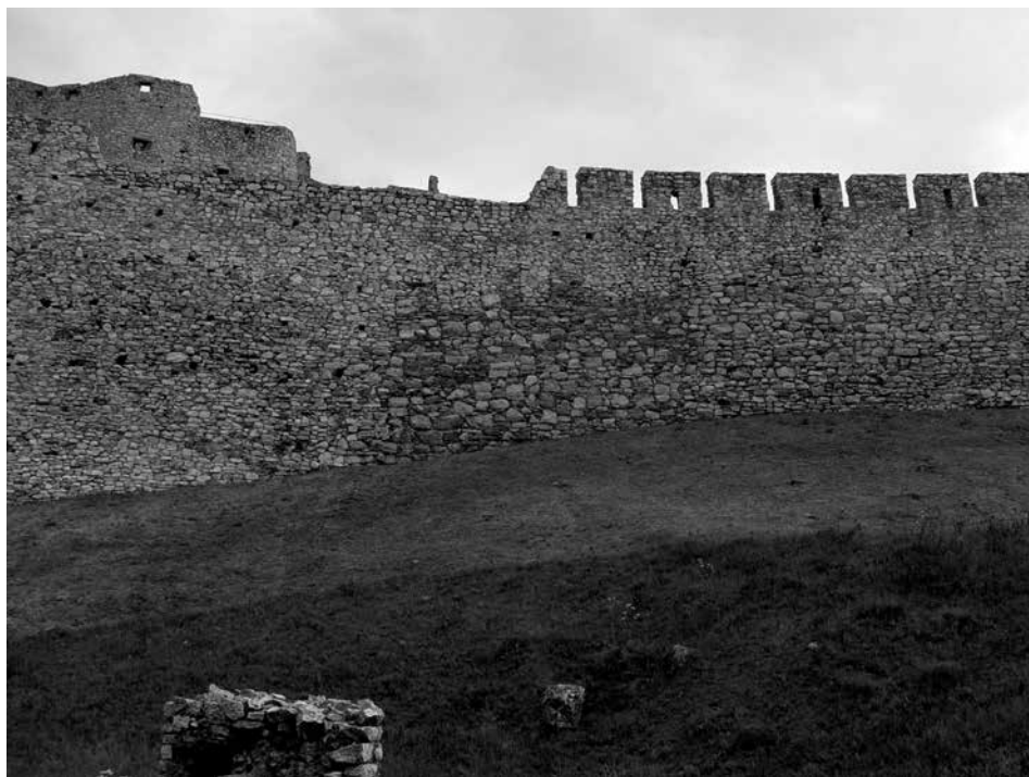
Obr. 7. Spišský hrad. Pohľad na zamurované staršie cimburie v opevnení medzi stredným a spodným predhradím. Foto M. Janovská. Abb. 7. Zipser Burg. Blick auf die vermaurten älteren Zinnen in der Befestigung zwischen mittlerer und unterer Vorburg. Foto M. Janovská.
