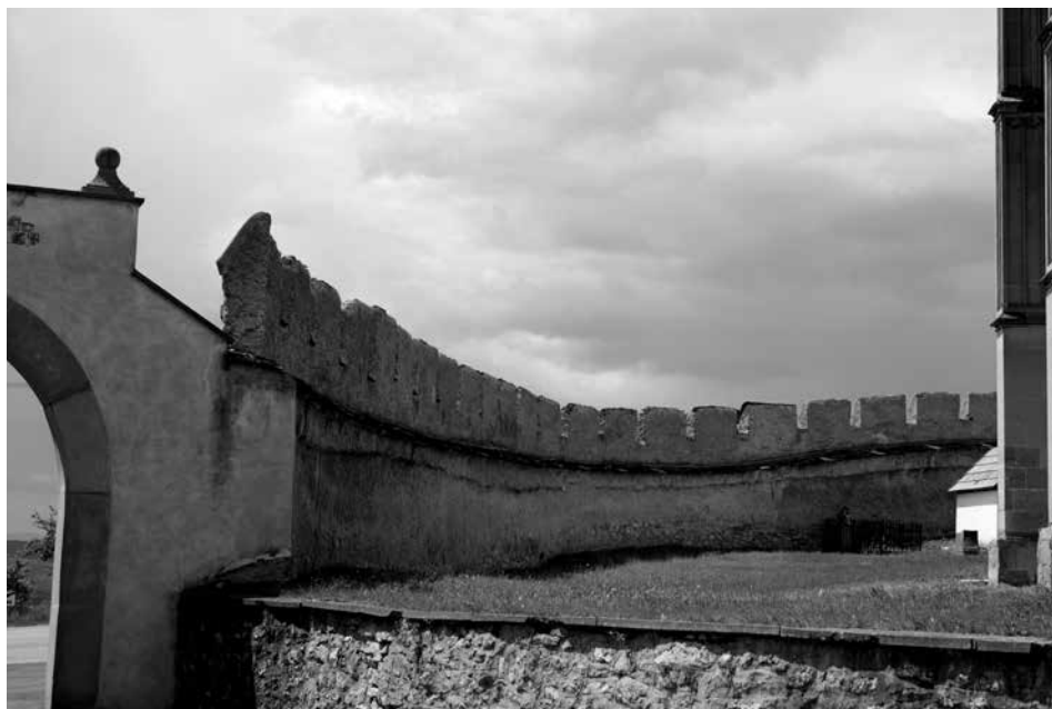
Obr. 13. Spišská Kapitula. Pohľad na opevnenie na južnej strane, ukončené cimburím, so stopami po staršej ochodzi. Foto M. Janovská. Abb. 13. Zipser Kapitel. Blick auf die mit Zinnen abgeschlossene Befestigung auf der Südseite, mit Spuren des älteren Wehgangs. Foto M. Janovská.
