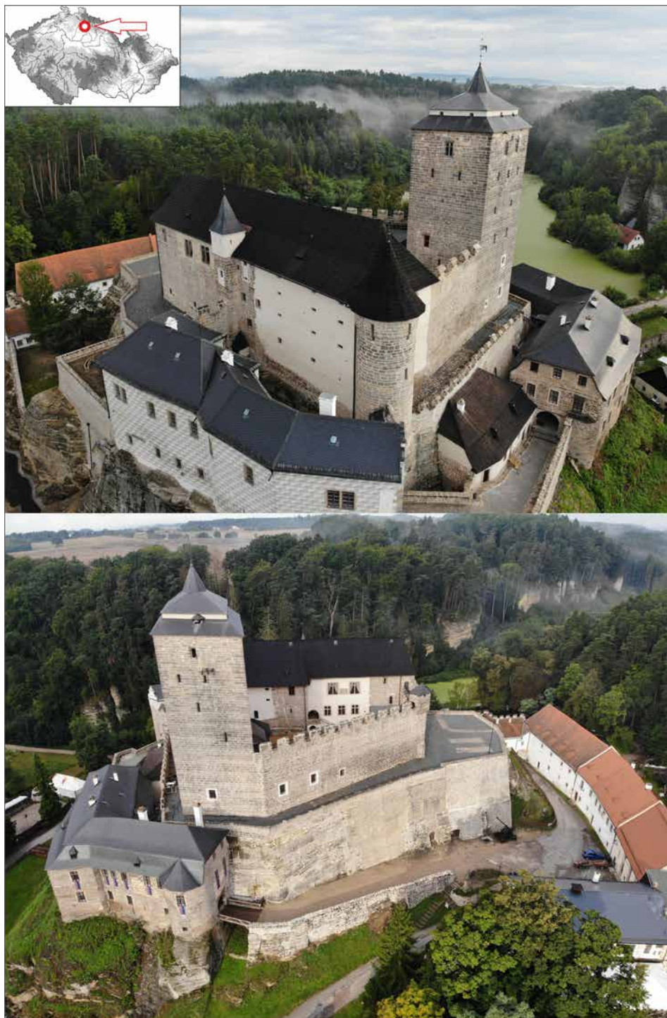
Obr. 1. Hrad Kost, současný stav. Nahoře pohled od jihozápadu, dole od jihovýchodu. Foto J. Unger. Abb. 1. Burg Kost, heutiger Zustand. Oben Blick von Südwesten, unten von Südosten. Foto J. Unger.
