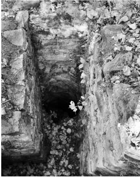
Obr. 6. Velešín, výklenek v toušče zdiva zakončený jímkou. Foto J. Varhaník, 2017.
