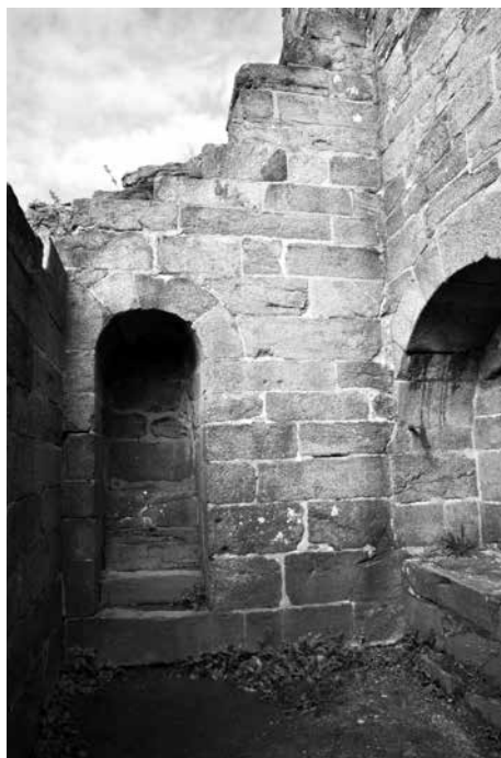
Obr. 2. Přimda, interiér přízemí rizalitu s prevetem. Foto J. Varhaník, 2016.
