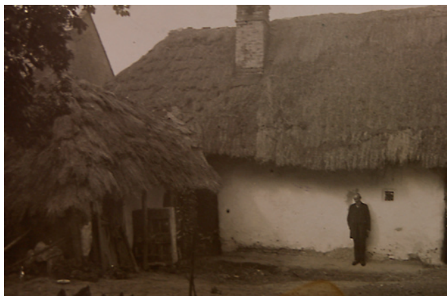
Obr. 4. Nádvoří část domkářského stavení čp. 55 v Předmostí. Na snímku je patrné podepření převislé střechy chlívků dřevěnými sloupy. SOKA Přerov.
