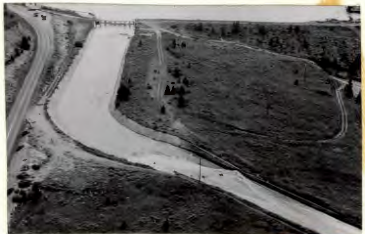
Fig. 11 SPILLWAY CHUTE (M. P. Co. Photo)
