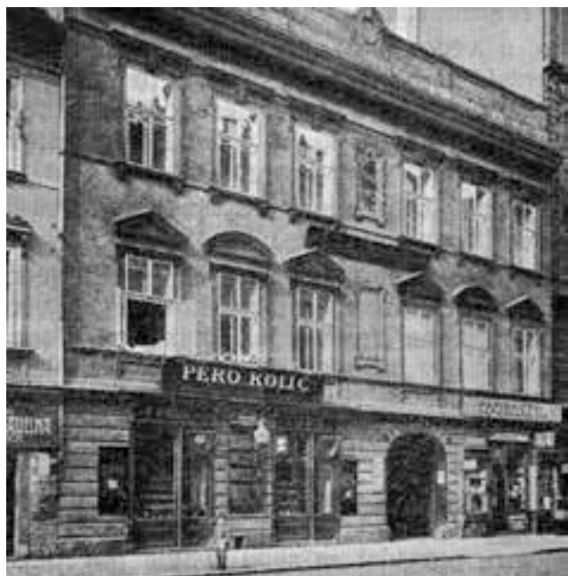
Průčelí domu v Jungmannově ulici k r. 1913
