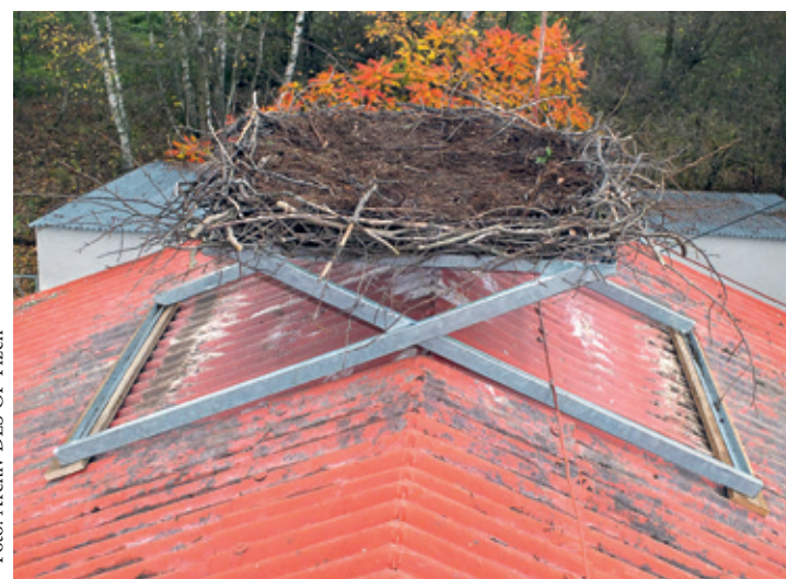
Umělá hnízdní podložka pro čápa bílého na klasické sedlové střeše budovy skladu s imitací rozestavěného hnízda. Hlíně, okres Tachov.
