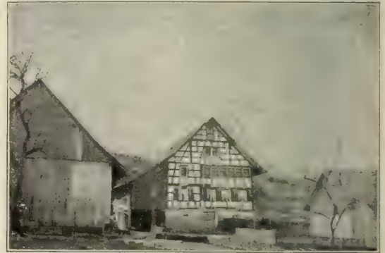
Maison en règle-mur à Tobel, Zurich.
