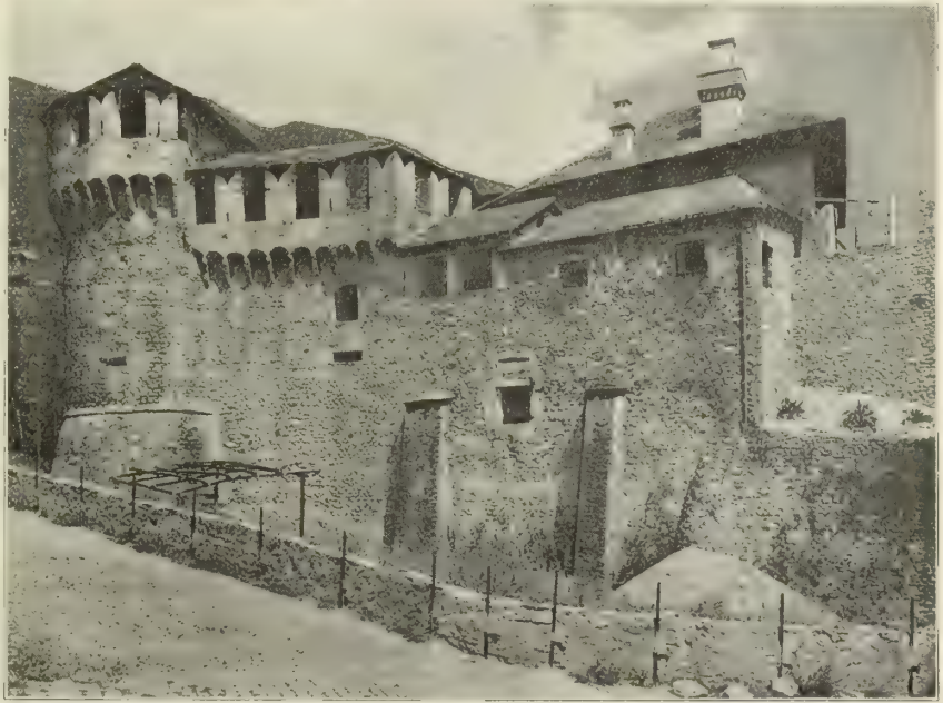
Le château de Locarno. D'après une photographie.
