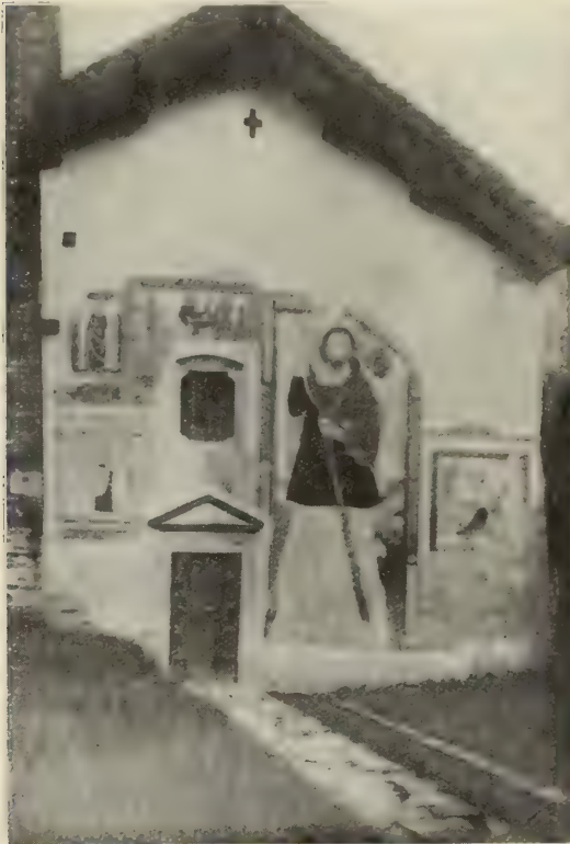
Façade de l'église de Malvaglia. D'après une photographie.
