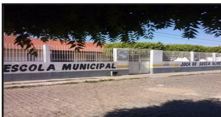
Figura 01: Fachada da escola
