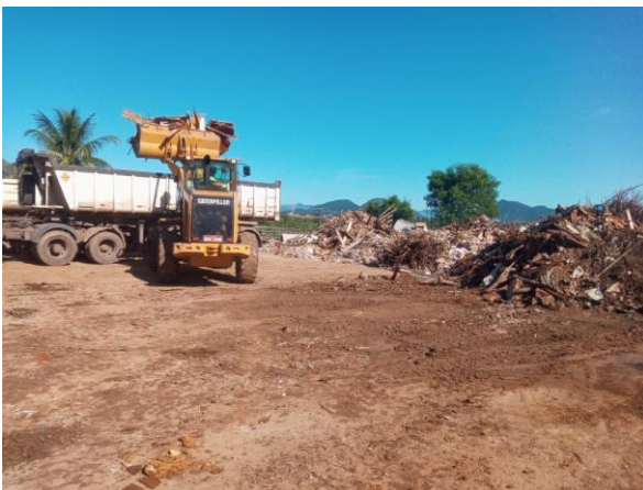
Execução do serviço de manejo na ATT de Nova Carapina II.
