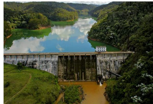
Barragem da PCH Rio Bonito
