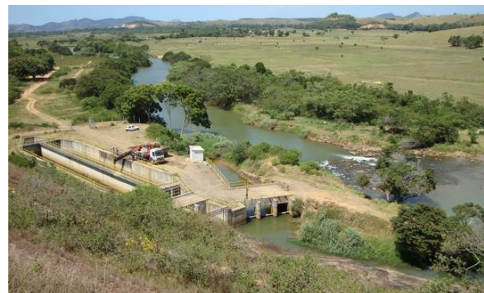
Captação no Rio SMV
