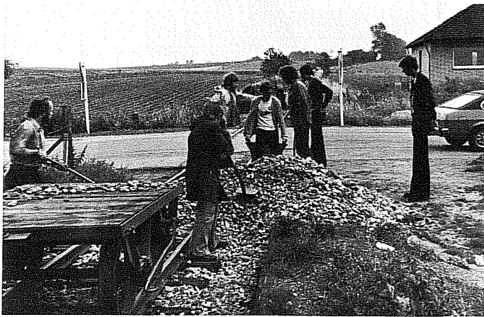
Gleisbauarbeiten im Juli: Einschottern im Gleisbereich an der Kreisstraße bei Starzend. Die IHS-Rotte wird gerade wirkungsvoll von einigen DEV-Mitgliedern mit und ohne Schaufel unterstützt. Am gleichen Tage war die Fahrt zur Touristikbahn bei Warsage angesetzt, und die Selkantbahn hatte daher wieder Besucher aus den Reihen der Ersten Museumseisenbahn in Bruchhausen-Vilsen.
