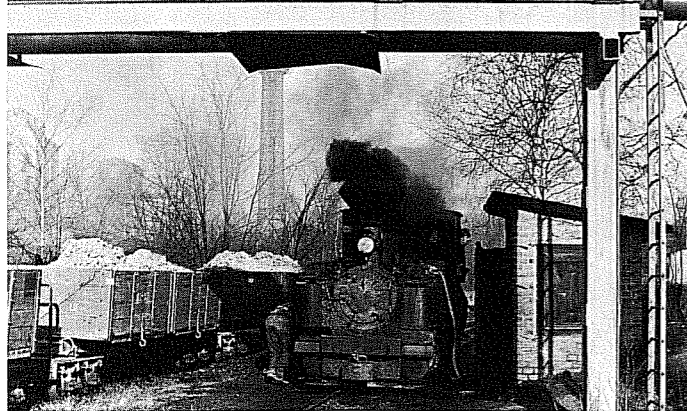
Die Lok 99 3315 nimmt Wasser. Links steht ein Tonzug, den sie von Mühlrose gebracht hat.
