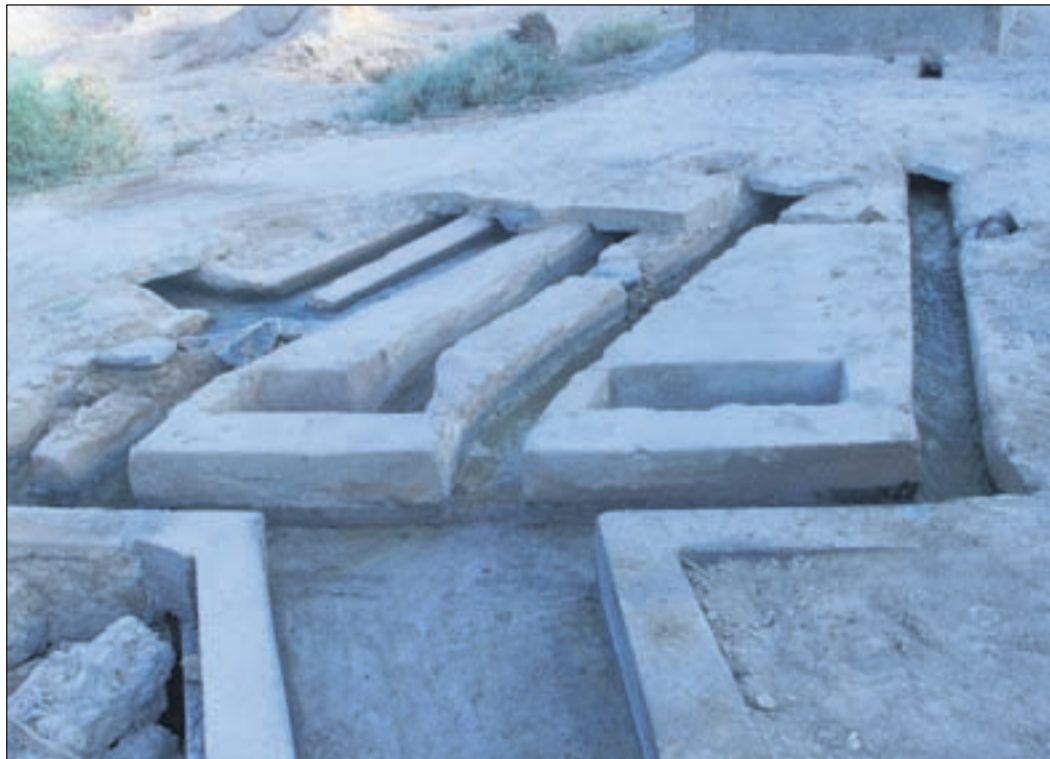
Le système de distribution par canaux peut être très complexe comme dans ce cas. Quand il n'est pas possible de le construire, on profitera du moindre détail topographique pour assurer la distribution (Ph. Association Zouzfana)
