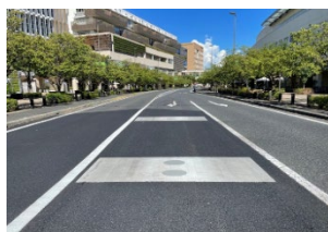
非接触給電装置
