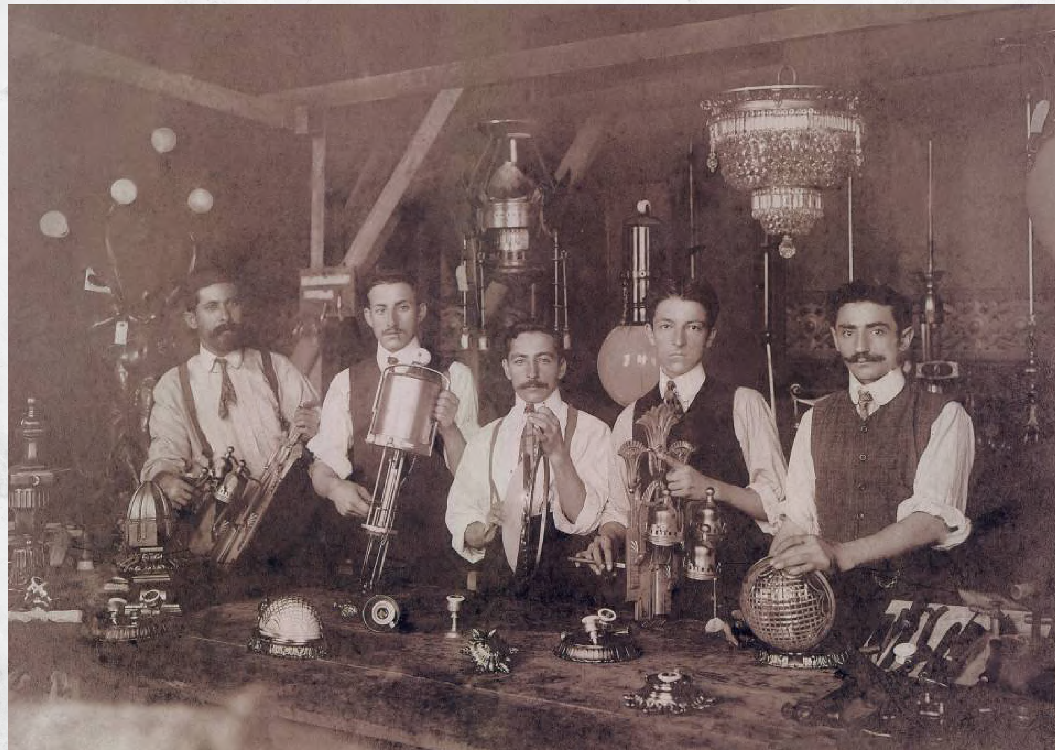
Conservadores das Luminárias durante a Reforma de 1934 (1934-1936)
