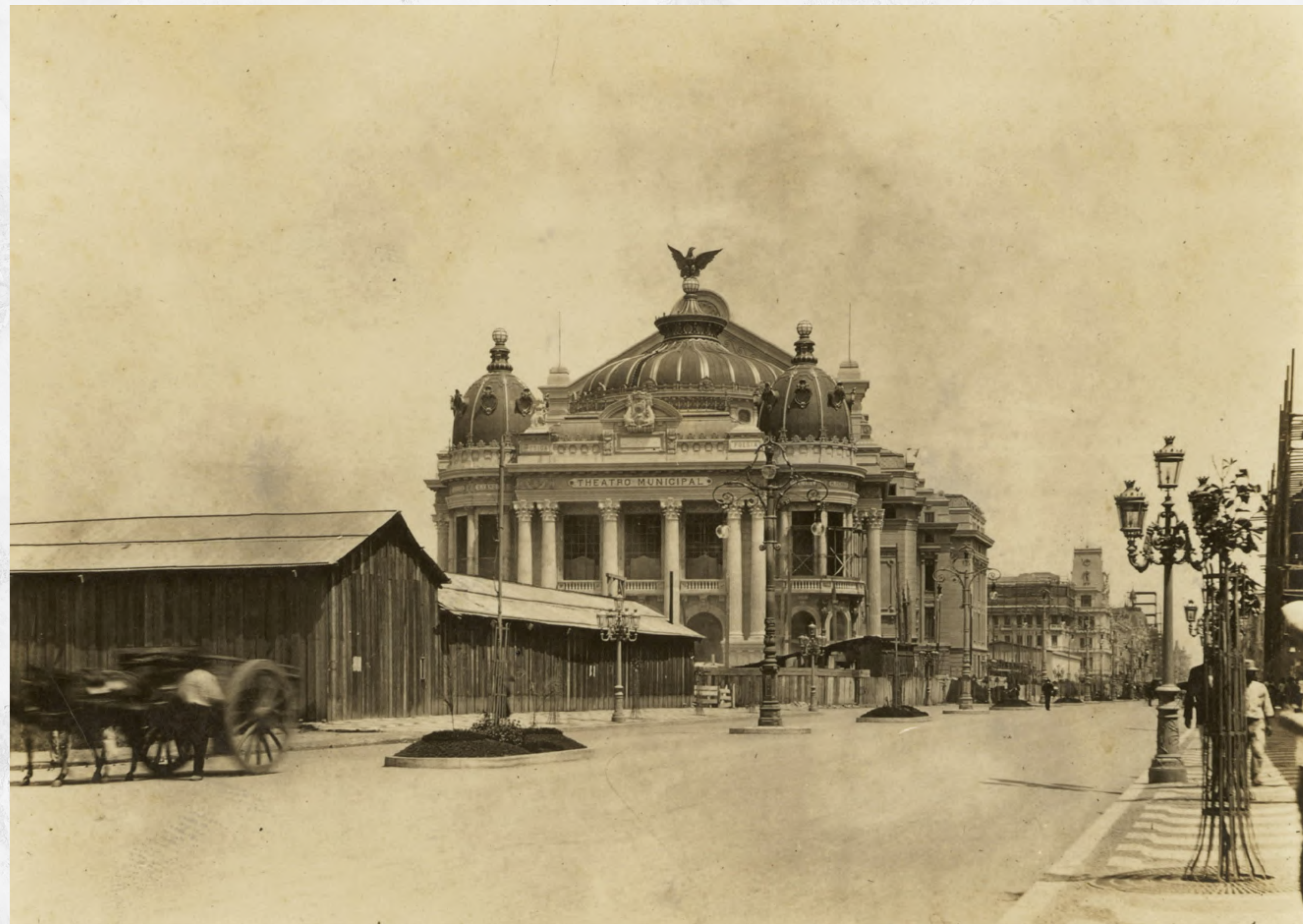
Prédio do Theatro Municipal erguido mas ainda apresentando o barracão da obra. (1909)
