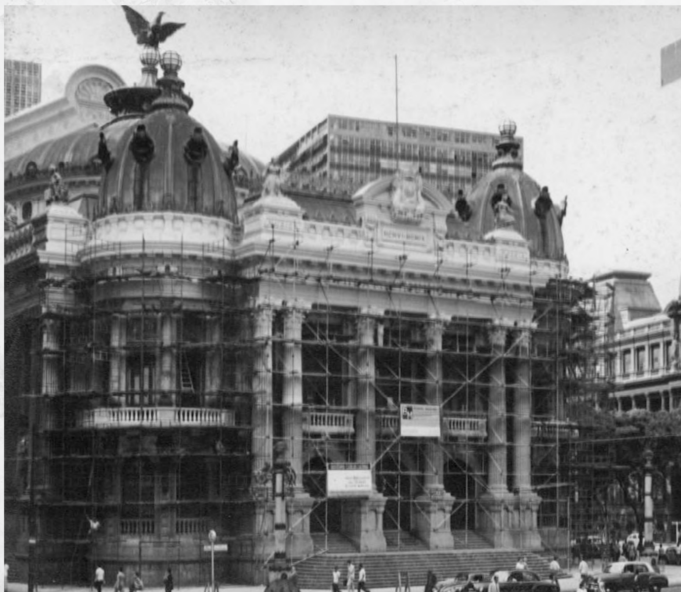
Fachada do Theatro durante a Reforma da Década de 70. (1975-1978)
