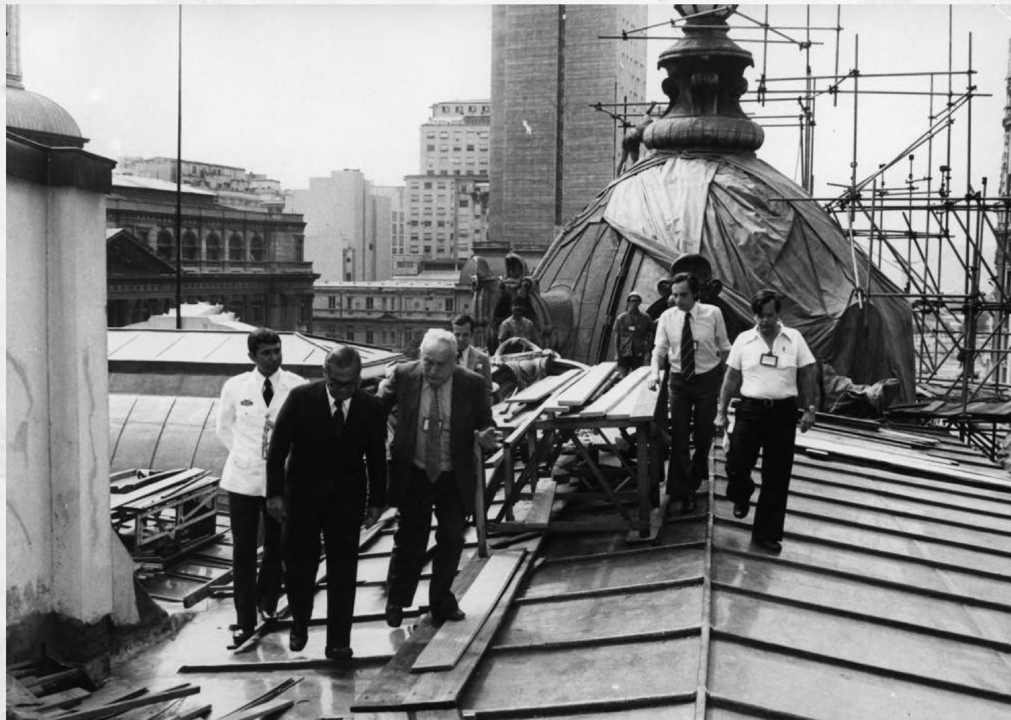
Telhado do Theatro durante a Reforma da Década de 70 (1975-1978)
