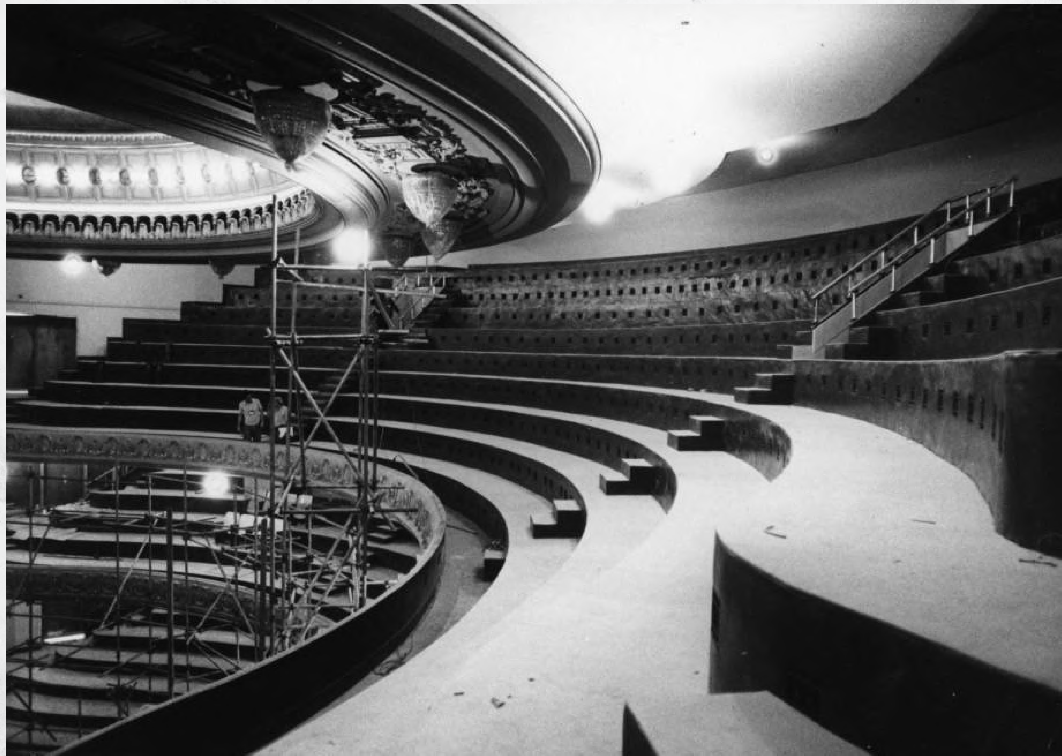
Interior da Sala de Espetáculos durante a Reforma da Década de 70 (1975-1978)
