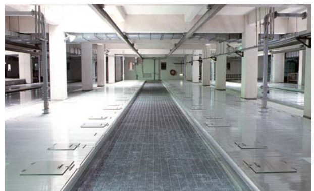
下水処理場 アルミニウム蓋として、耐食性・耐久性に優れ、臭い漏れのないファルカバを使用
