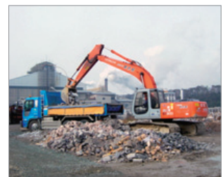
廃レンガのリサイクル化(福井工場)
