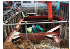
土壌入替工事
