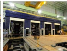
建設中の4スタンド 仕上圧延機
