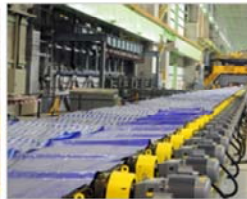
建設中の熱間圧延機
