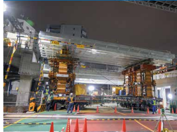
大型重機による道路交差部の桁架設状況(③)
