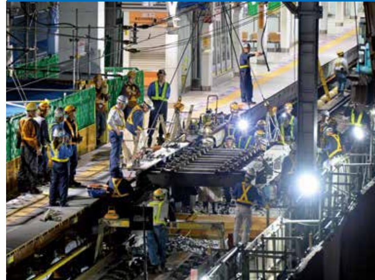
工所用仮桁の撤去状況(①)
