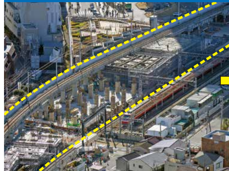
高架橋構築完了前
