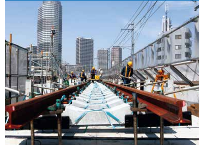
下り線 軌道敷設状況
