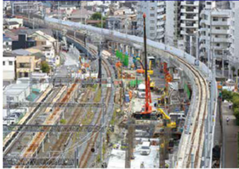
工事状況(曳舟方)
