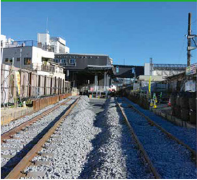
伊勢崎仮上り線軌道工事
