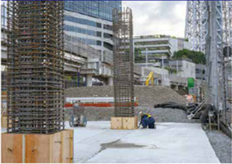
高架橋の構築工事の状況
