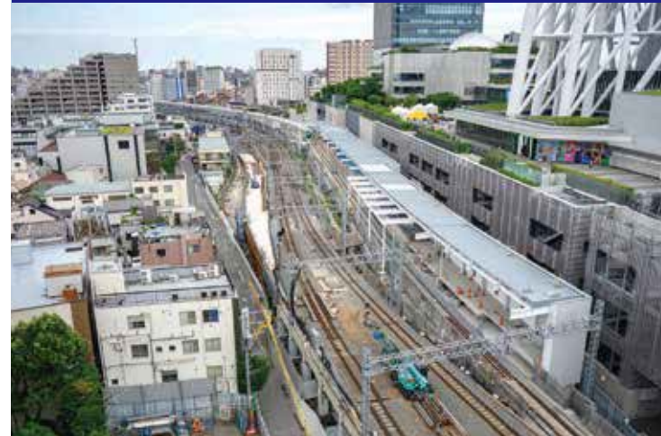
① 全景(駅部付近)
