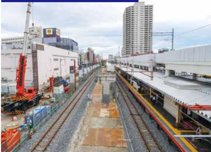
②下り緩行線高架橋上から見た駅部
