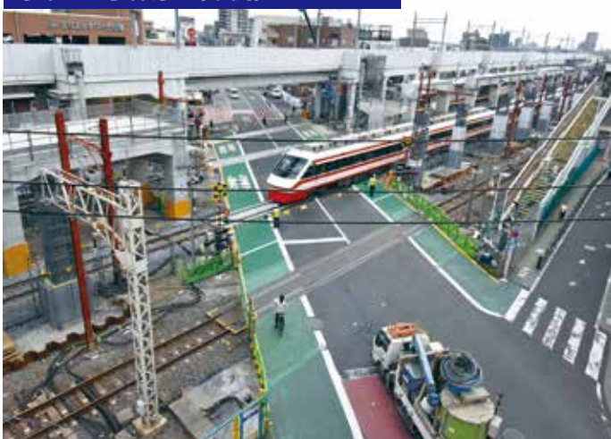
⑤第37号踏切道(東側)
