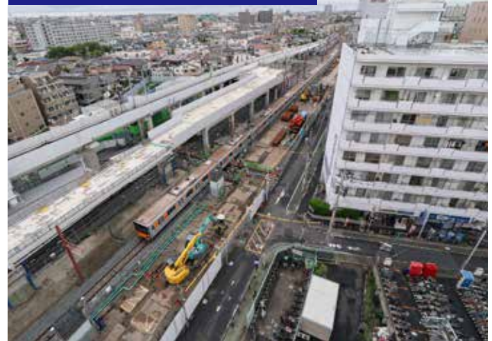
③第38号踏切道(東側)
