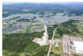
整備が進む日本海沿岸東北自動車道(大館能代空港付近)
