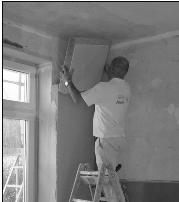
FIGURA F.2 - Aplicação de Isolante Acústico. FONTE: engenhariacivil.com.
