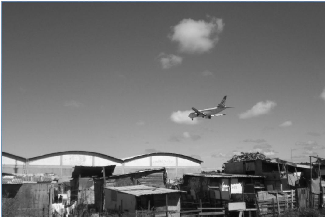
Figura 8-12: Galpões e habitações de baixa renda instalados na zona de aproximação do aeroporto de Recife. Fonte: Silva (2010).
