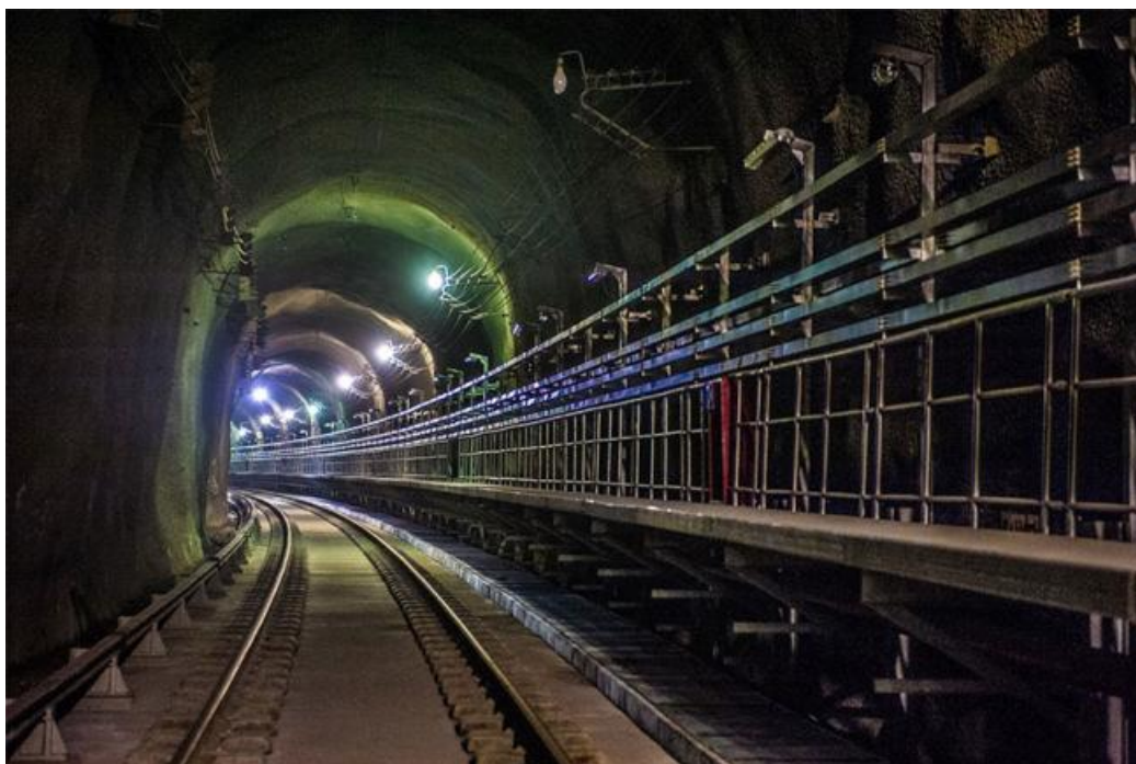
Figura 25: Via Permanente em processo de montagem na Linha 4 do Metrô do Rio de Janeiro. Fonte: VIATROLEBUS (2015).
