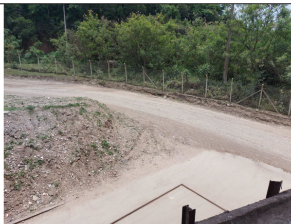
Detalhe do acesso interno, trafegável, e ao fundo o alambrado que cerca todo o perímetro do transborbo.
