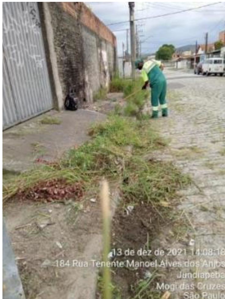
Figura 14 - Serviço de raspagem
