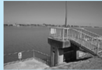
駐車場前の下幡木3号水門
