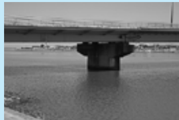
鱈川橋(水郷有料道路)の橋脚周り
