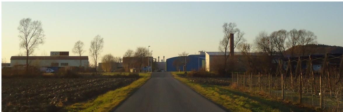
Abbildung 4: Fotostandpunkt Nr. 2. Blick Richtung Westen. Bereich südlich der Bahntrasse; Erschließung Osten (Quelle: PLANUM, Ch. Harg, 10.12.2015)
