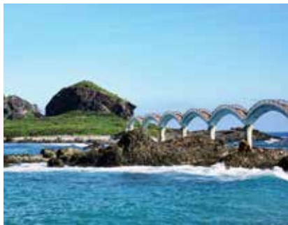
臺東三仙台 ထိုင်တုန်း Sanxiantai
