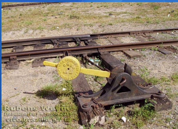
Foto nº 11: Detalhe de alavanca manual de manobra de AMV
