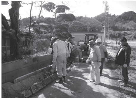
石堀・落下物の撤去作業の様子
