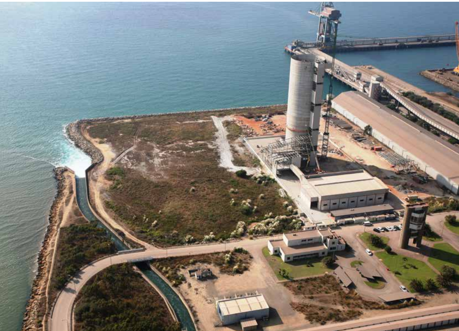
Central térmica Los Barrios, Cádiz
