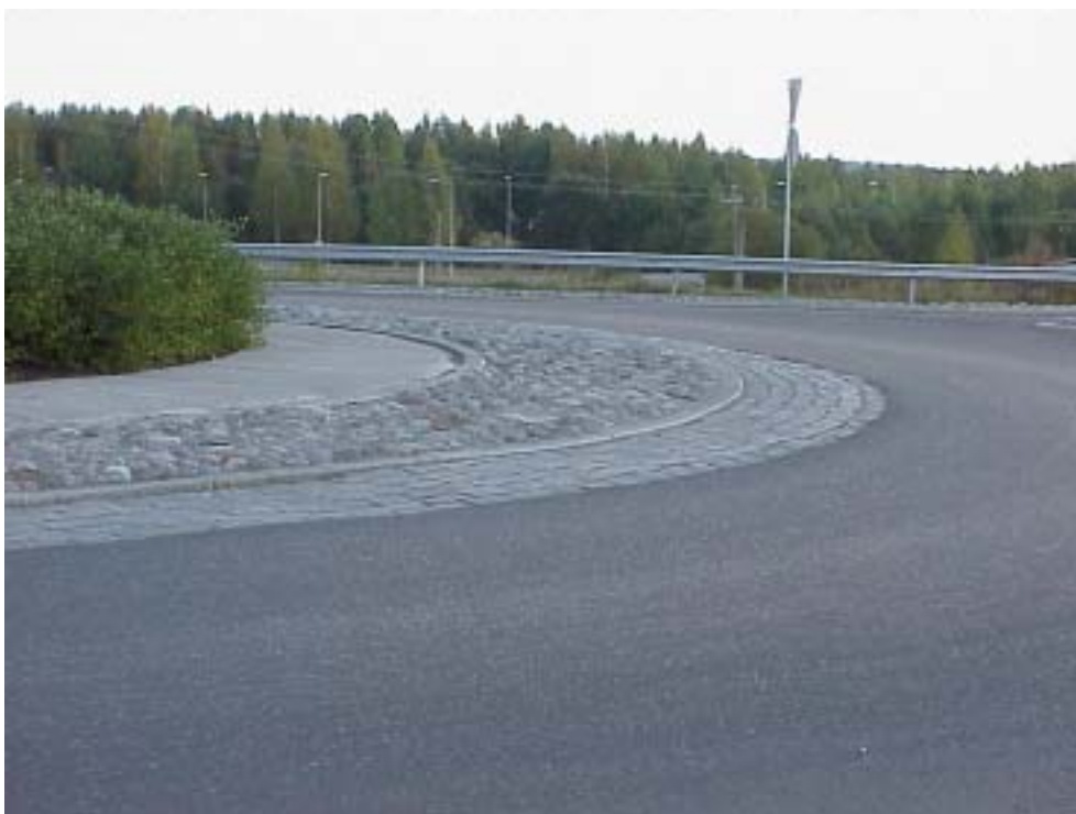
Kuva 5.10 Epätasaisella materiaalilla toteutettu yliajettava oikaisutila. Epätasainen pinnoite hillitsee henkilöautojen oikaisuhalua, mutta sallii raskaan liikenteen oikaisun.
