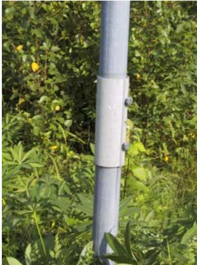
Kuva 5.27 Katkaisemaan joudutut liikennemerkit korjataan liitosholkilla (Veli-Matti Leppälä).
