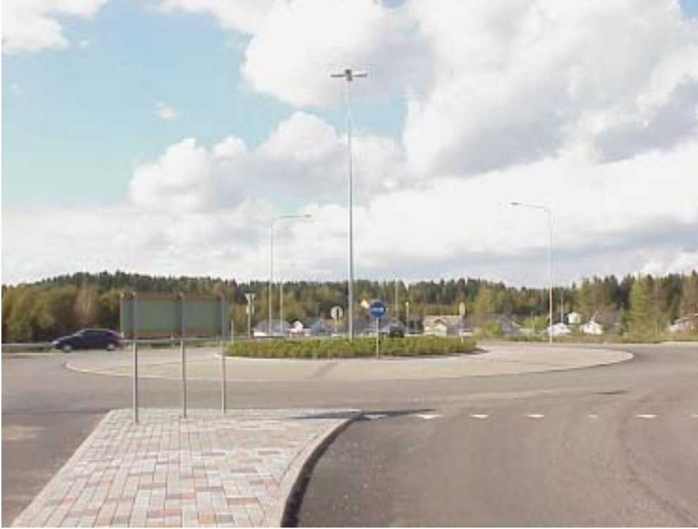
Kuva 5.5 Erikoiskuljetusten kannalta hyvin toteutettu kiertotilan kavennus.
