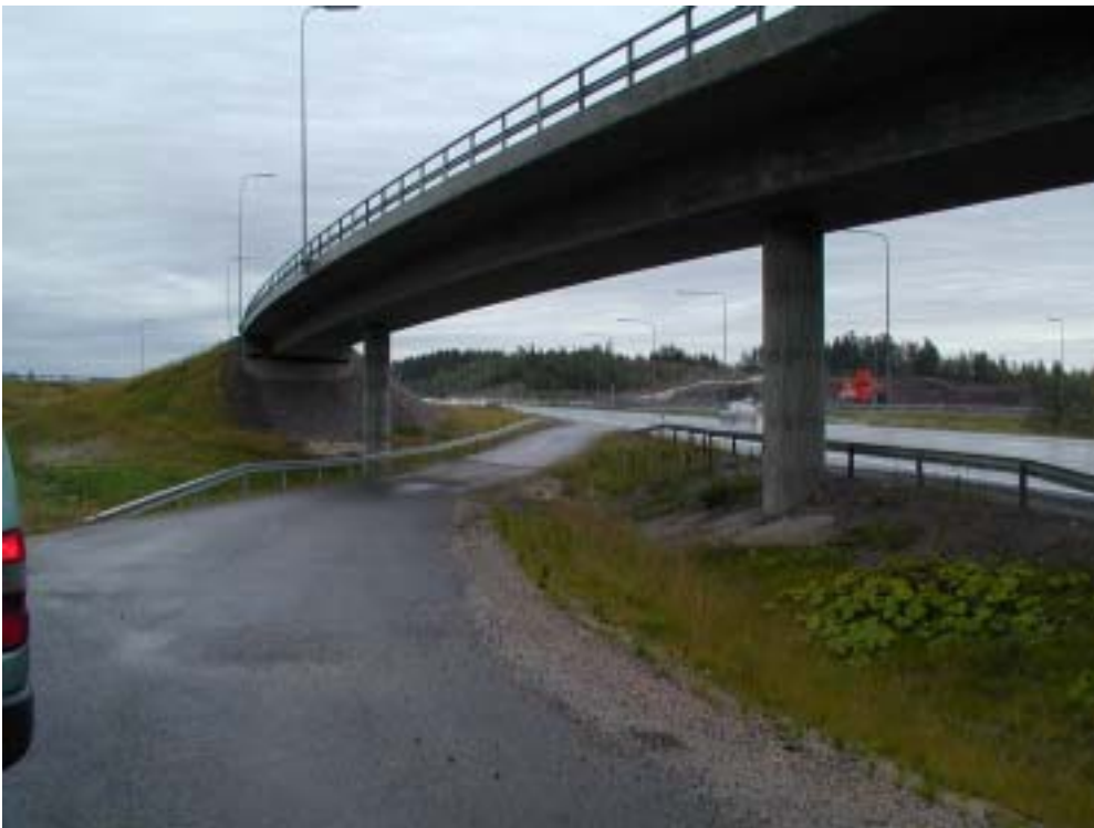
Kuva 5.11 Joutjärven eritasoliittymän risteyssillan ali rakennettu erikoiskuljetuskierto.
