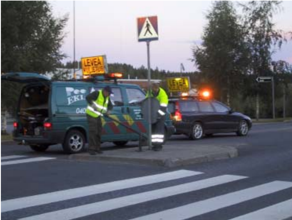
Kuva 5.26 Suojatiesaaressa olevaa liikennemerkkiä poistetaan erikoiskuljetuksen kulkureitiltä (Veli-Matti Leppälä).
