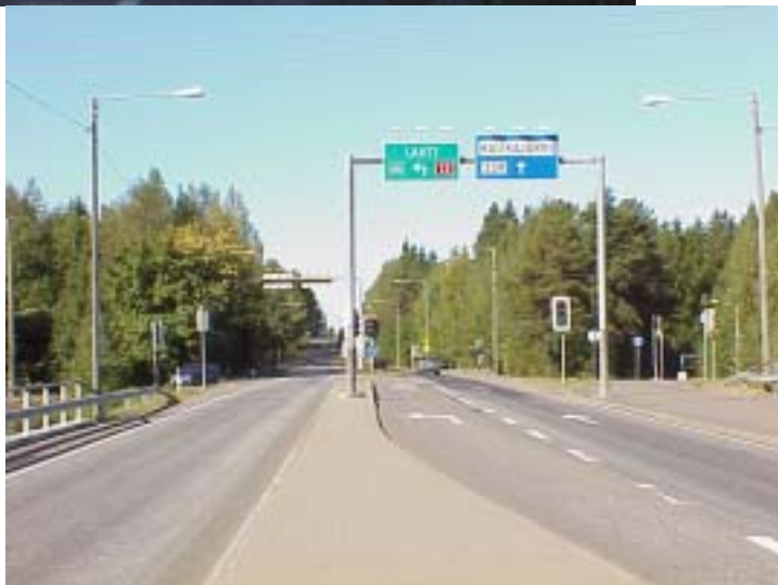
Kuva 5.16 Kokoportaaali, puoliportaali ja umpipuoliportaali.
