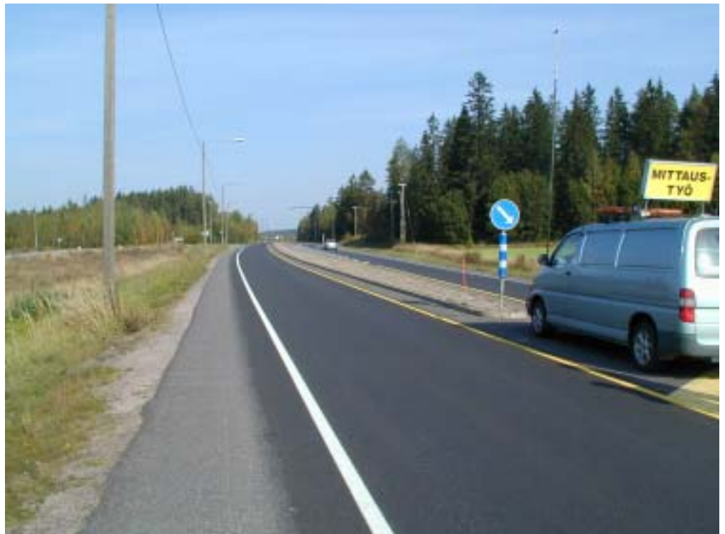
Kuva 5.24 Keskisaarekkeen ja valaisinpylvään muodostama portti.
