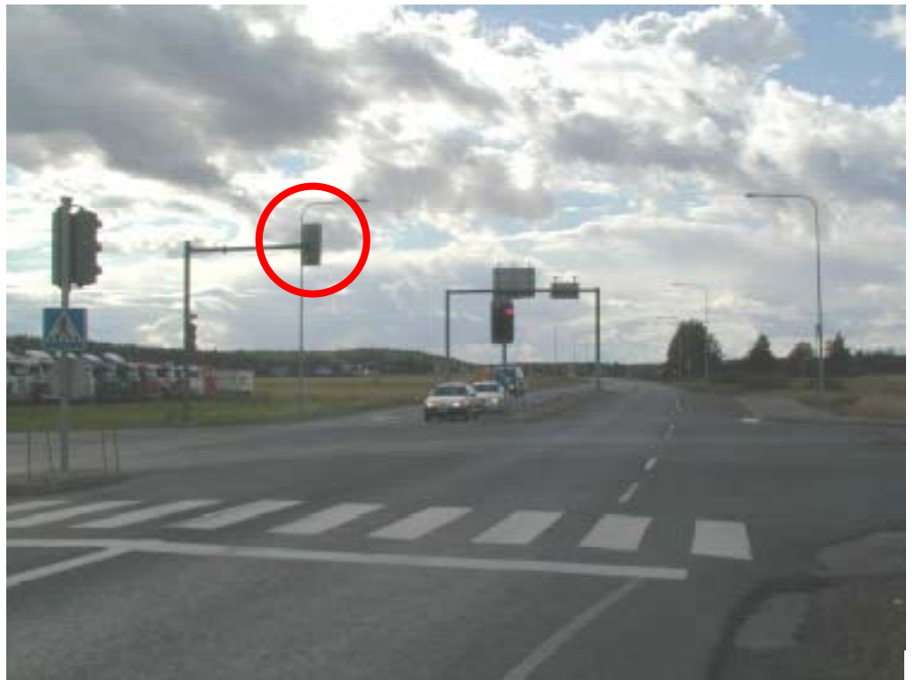
Kuva 5.29 Matala liikennevalo-opastin estää korkeiden kuljetusten kääntymisen liittymässä.
