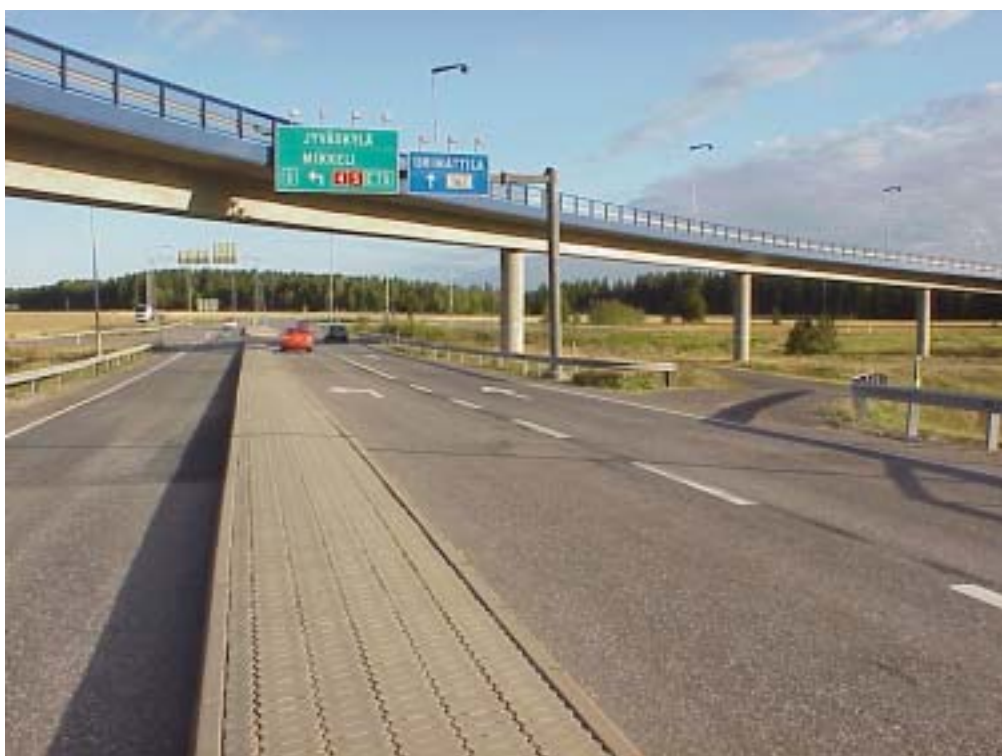
Kuva 5.12 Liian ahdas kulkuaukko erikoiskuljetuskierrolle Lahdessa Renkomäen eritasoliittymässä.
