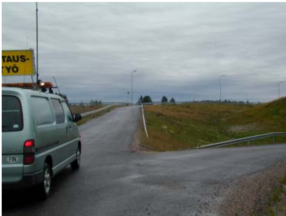
Kuva 5.13 Liian kapea erikoiskuljetusramppi rajoittaa sen käyttöä leveissä kuljetuksissa.
