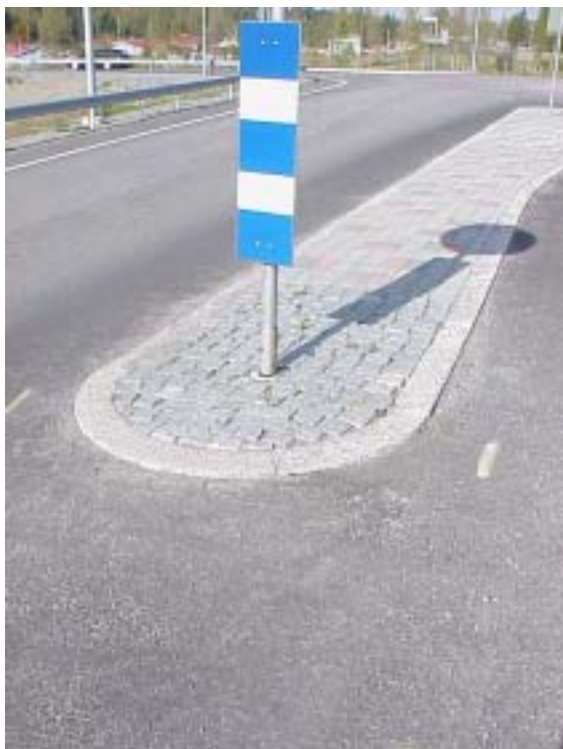
Kuva 5.9 Erikoiskuljetuksia varten yliajettavaksi rakennettu keskisaa- reke.
