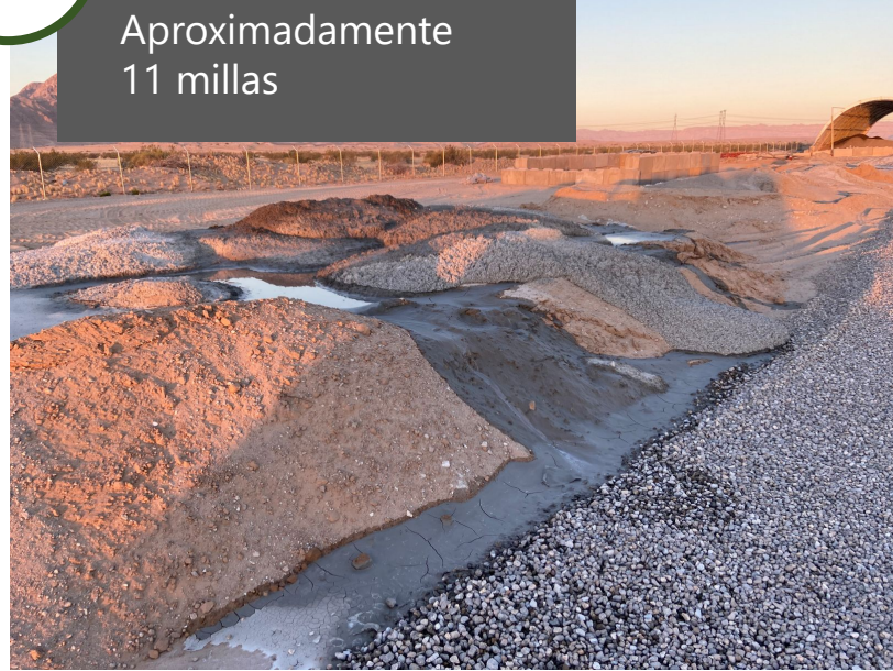
Derecha: Obra vial en el Sector El Centro
