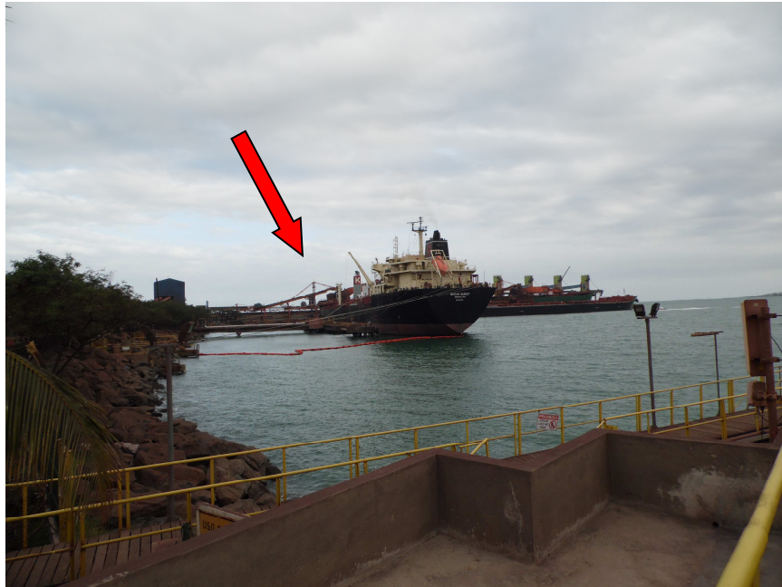
Figura 52 – Terminal de Granéis Líquidos – Cais (a seta indica o posicionamento do NT em relação ao TGL).
