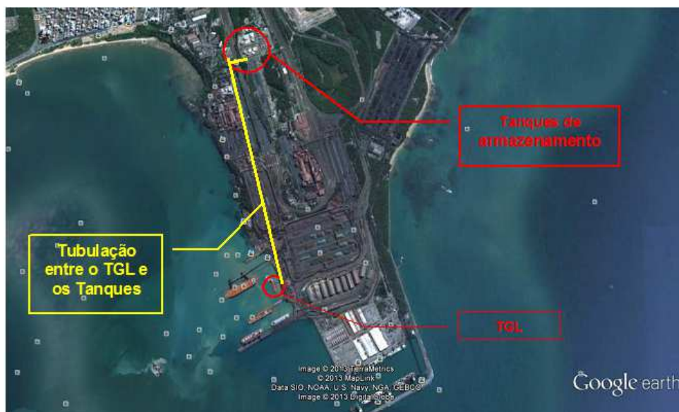
Figura 47 – Vista aérea do TGL, da tubulação e dos tanques de combustíveis (Adaptado do Google Earth).
