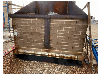
Chimney CH ( Brick Base)
