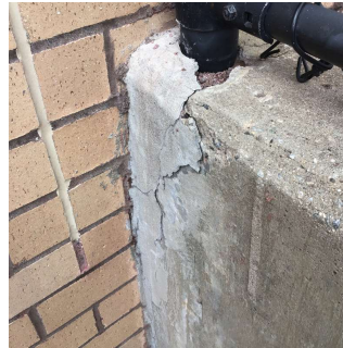
Facade C - AW2
