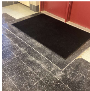
Stair C - Vestibule
