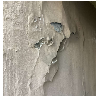
Facade A - AW1
