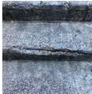
Facade A - AW1
