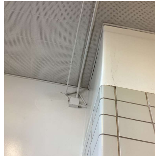
Stair A/1 - Vestibule
