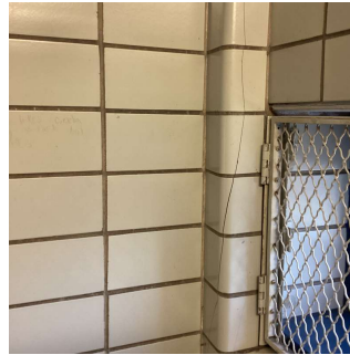
Stair A/1 - Vestibule
